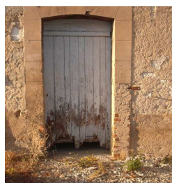
Porte avant travaux
